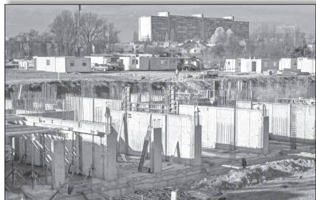
dvije od izvođača na objektu A3. Za vrijeme pisanja ovog izvještaja obavljeni su iskopi, izbetonirane su temeljne ploče i odvijaju se tesarski i armirački radovi na nižim etažama na sva tri objekta. Radove otežava i usporava kiša koja je tijekom jeseni učestalo i dugotrajno padala, no bez obzira na to, raspoloženje i radna atmosfera su dobri i nalazimo se unutar svih planiranih rokova.
